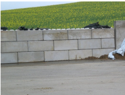
Abb.: Hangabsicherung
